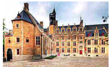
Gruuthuse à Bruges
